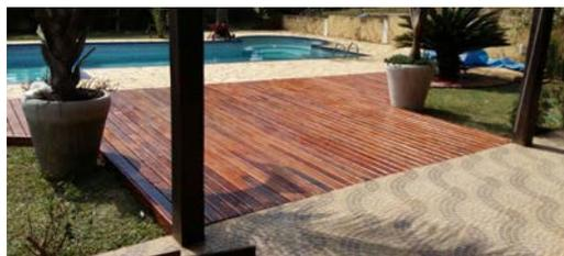
A garapeira possui alta resistência ao cupim de madeira seca, mesmo assim pede a aplicação de uma seladora para aumentar sua durabilidade. É empregada em parapeito, estrutura de telhado ou casa de madeira, vigas, caibros, ripas, tábuas, tacos para assoalhos, batentes de portas e janelas.
